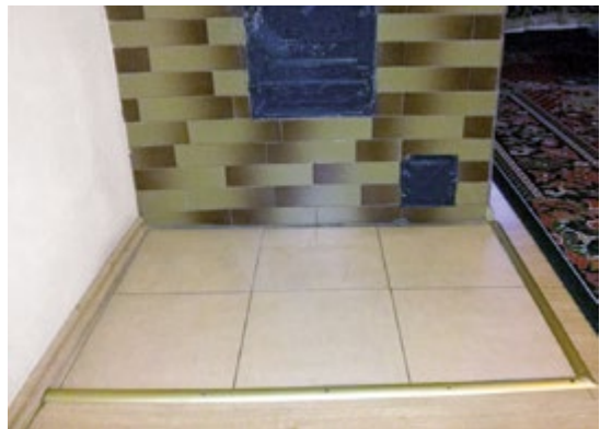
Grindys šalia krosnies nuo žiežirbų apsaugotos keraminėmis plytelėmis
