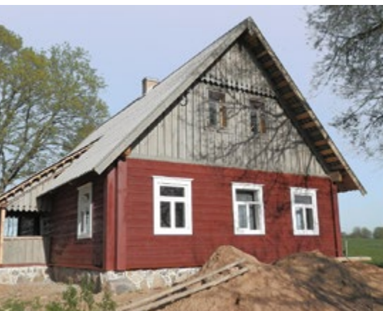
Tinkama kaimo pirkios sienų apkala ant šiltinamosios medžiagos
