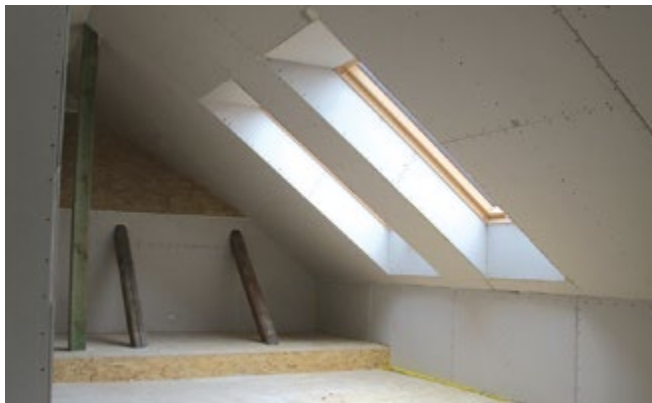
Apšiltinta ir gipskartonio plokštėmis aptaisyta palėpė
