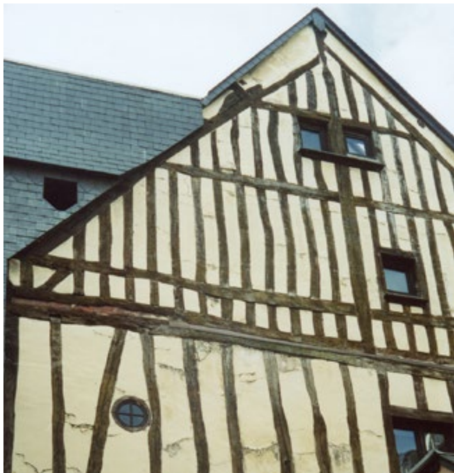
Karkasinės konstrukcijos pavyzdys
